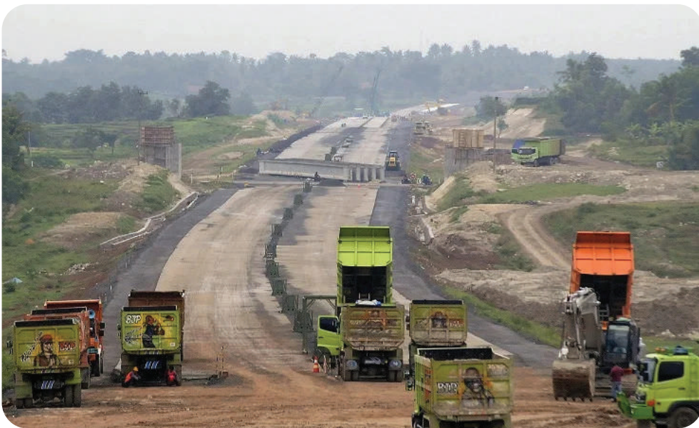
Gambar 3.2 Pembangunan jalan merupakan salah satu penerapan fungsi pajak.
