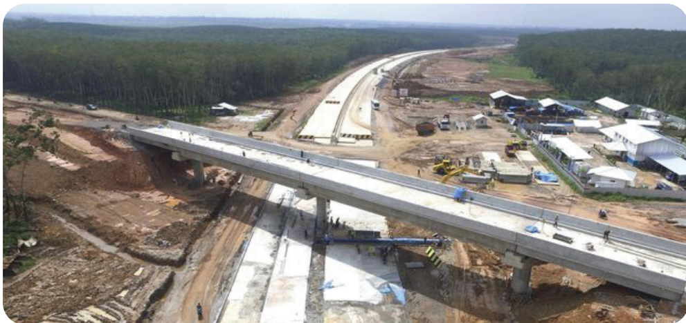
Gambar 1.2 Pembangunan jalan tol.
